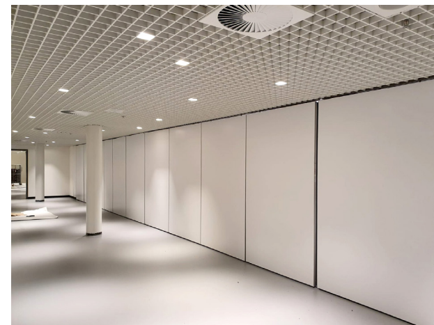
Beeld links: project Grimbergen: "We hebben de verweerde aluminium panelen behandeld en voorzien van rode gevelfolie." Beeld rechts: Rotterdam Ahoy.
