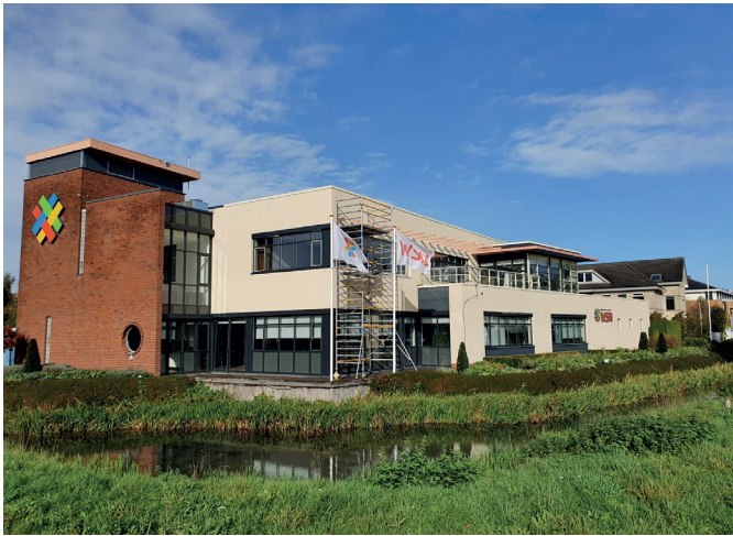
“Alle aluminium kozijnen en panelen, alsmede de garagedeuren bij Woningstichting Nijkerk zijn door ons voorzien van Avery Facadefilm, in de kleur Ral 7021 zijdeglans.”
