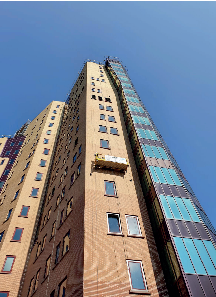
“Onze jongens hebben gewerkt vanuit hangbruggen en steigers, aan drie zijden van het enorme gebouw.”
